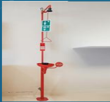
Vòi rửa mắt và vòi tắm khẩn cấp Emergency Eye Wash and Shower
