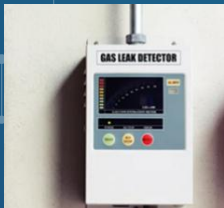
Hệ thống phát hiện rò rỉ khí Ammoniac Leak Detection Systems for Ammonia
