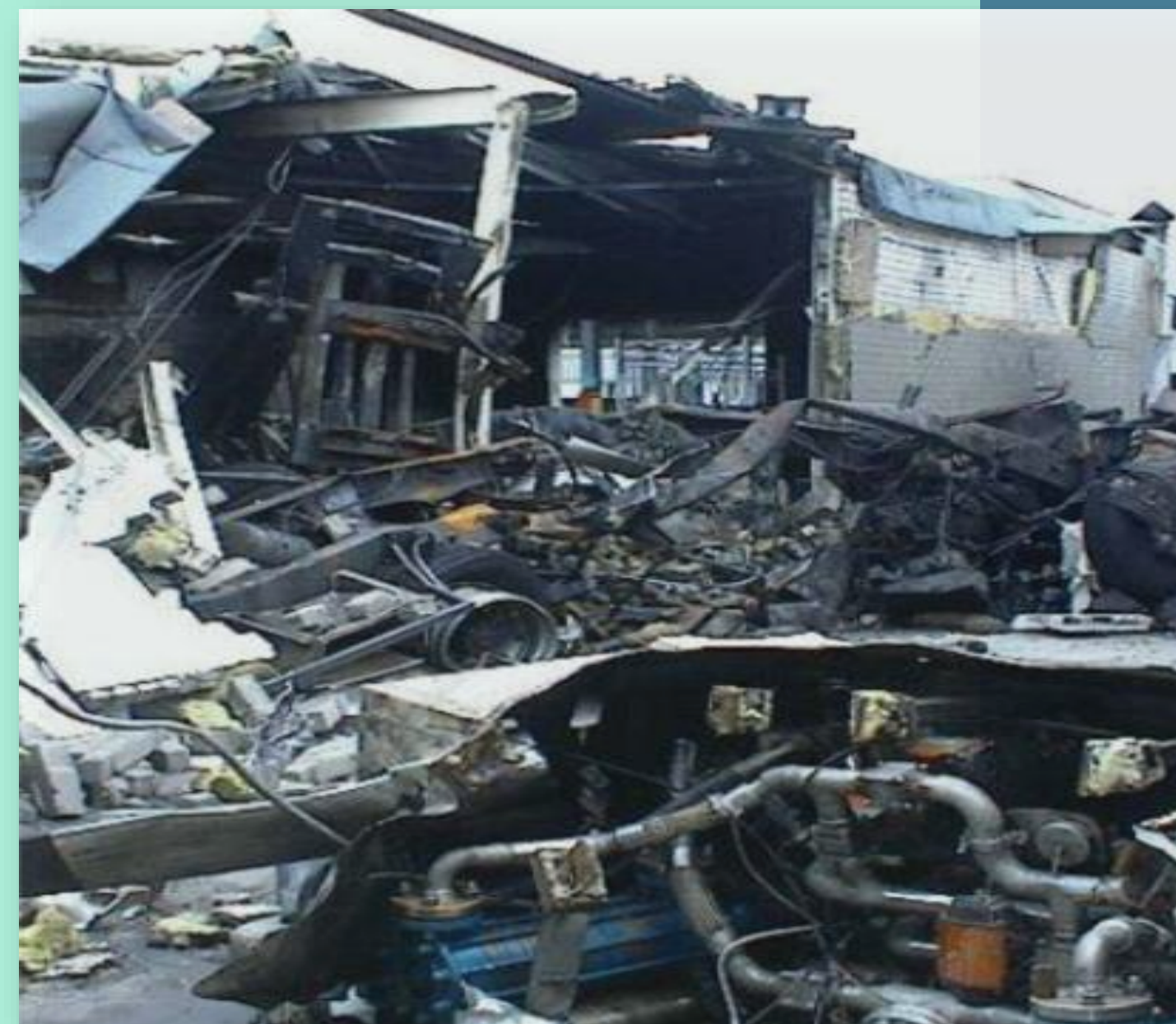
Hình 2. Nổ bồn ISO N 2 O tại trạm nạp Explosion at N 2 O ISO Tank Filling station
