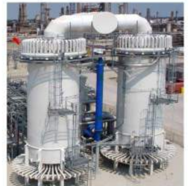
BỘ TẠO LỬA ĐÁY BOTTOM-FIRED REFORMER
