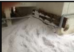
Góc hộp lạnh/ kết cấu bị nứt, lủng. Rò rỉ hạt cách nhiệt
